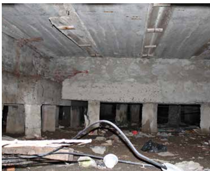
Рис. 3 – Проветриваемое подполье здания Округного центра национальных культур, г. Салехард, август 2018 г.
