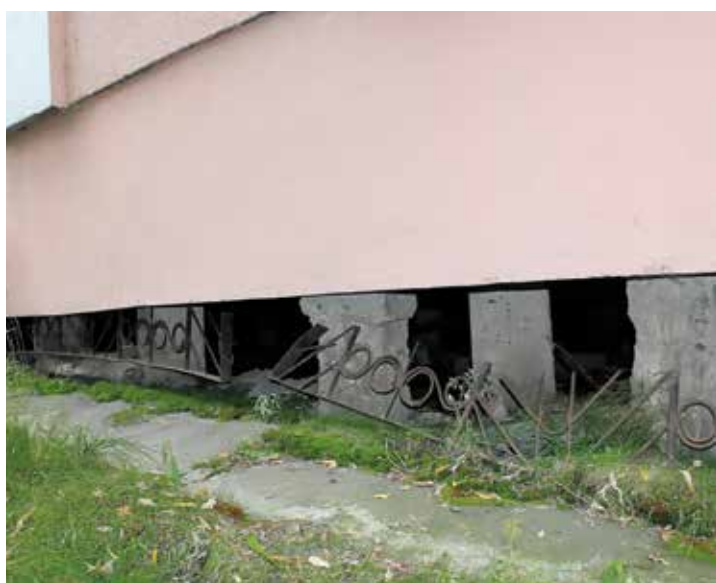
Рис. 3 – Проветриваемое подполье здания Округного центра национальных культур, г. Салехард, август 2018 г.
