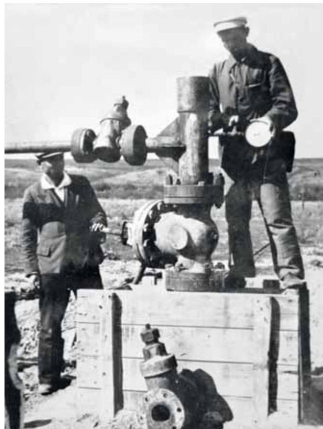
Ведутся работы на Елшанском месторождении / www.saratovnews.ru
