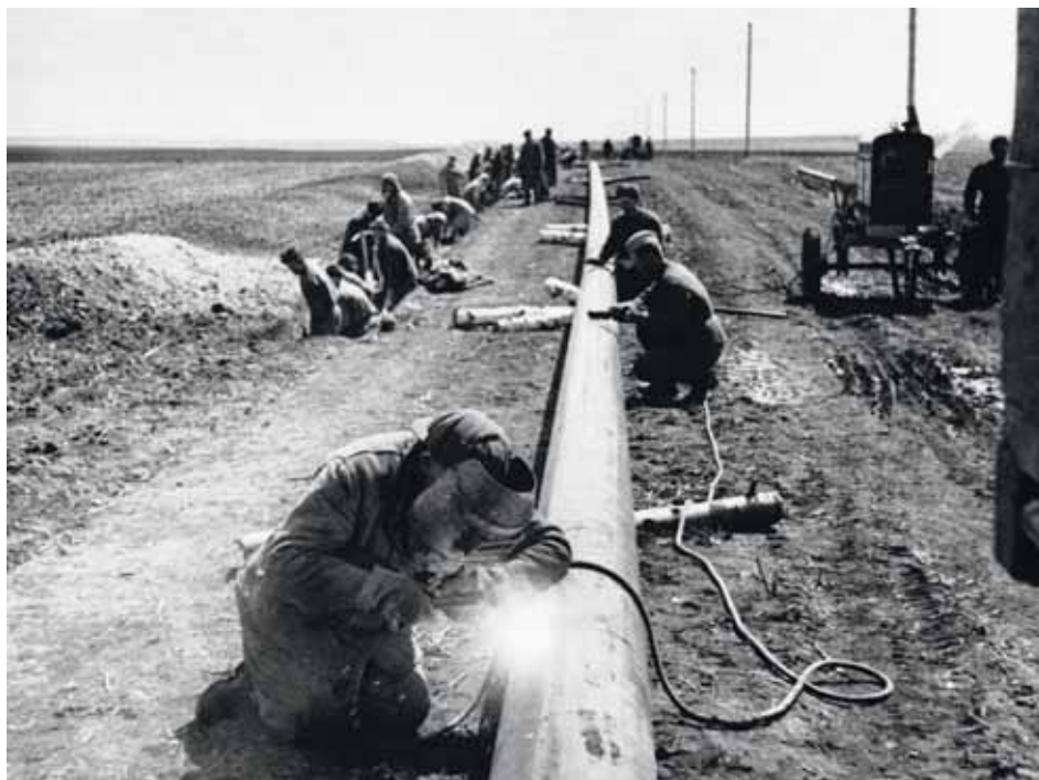
На строительстве газопровода «Саратов — Москва»
